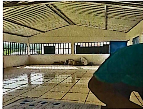
Terminación del aula
