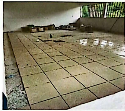
Colocación de piso cerámico
