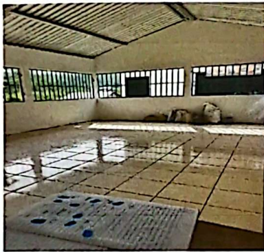
Terminación del aula
