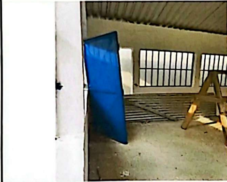
Colocación de puertas y balcones
